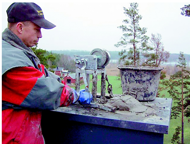
Kuvassa hormin tiivistysmassaus
